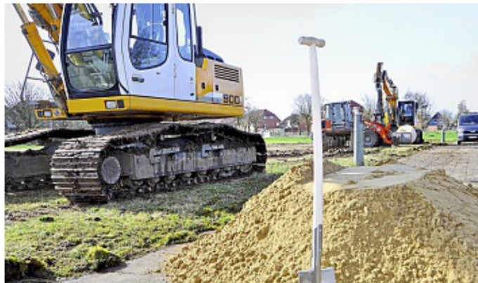
In zwölf Monaten soll auf dem alten Grandplatz die neue Sport- und Freizeitanlage entstehen.
